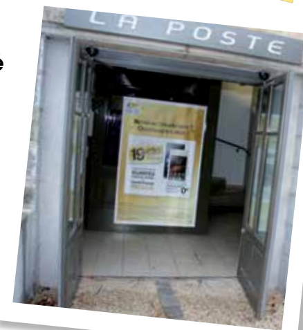
Bureau de poste de Mornant ayant fait l'objet de travaux d'accessibilité
